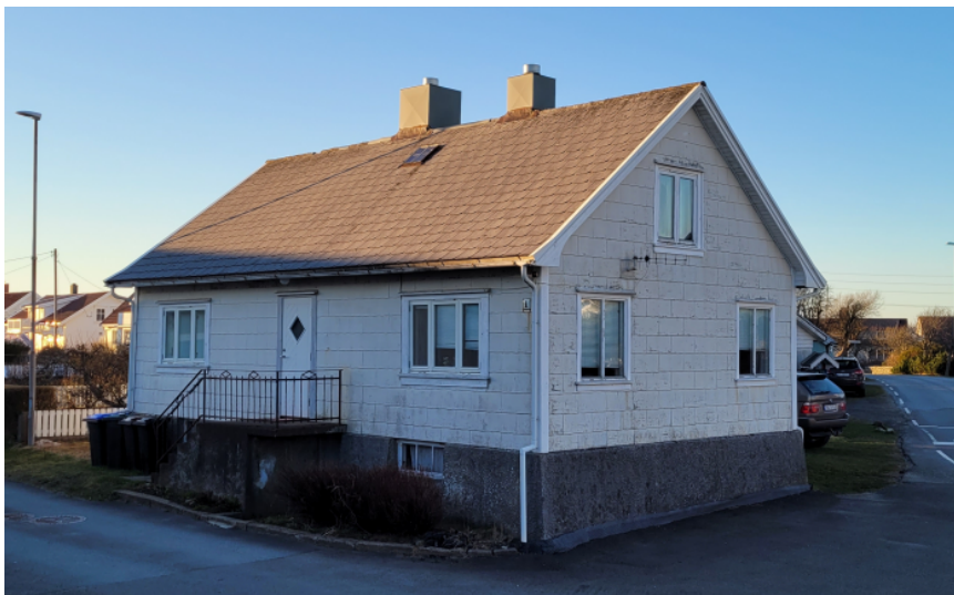
Eksisterende bolig som søkes endret
