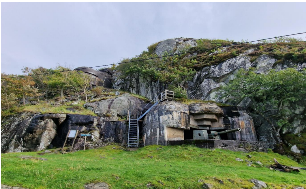
Figur 4: Bildet viser kommandobunker og 105 mm kanon i kasematt. Hentet fra mulighetsstudien.
