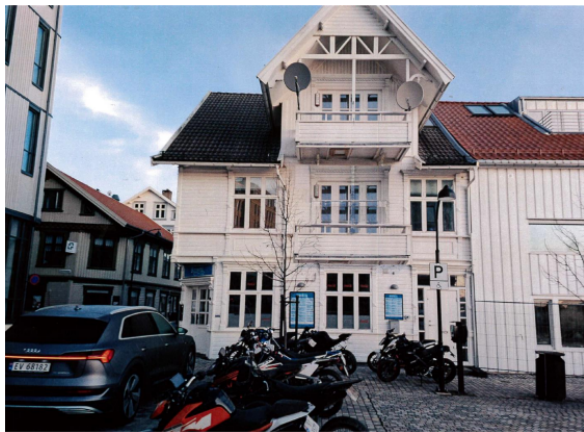
Fasade med ny altan i 2. etasje
