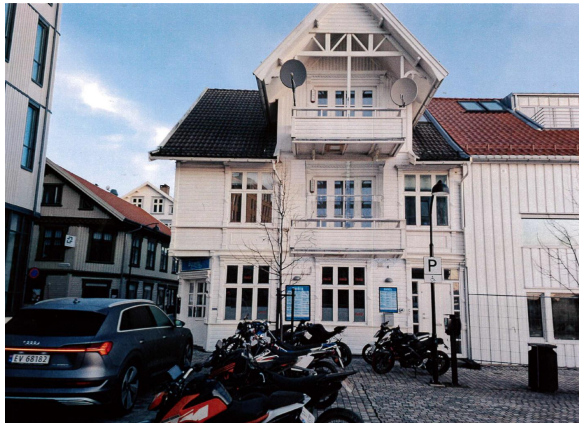
Fasade med ny altan i 2. etasje
