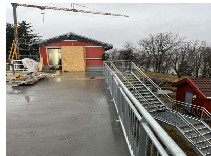
Varbak høydebasseng - Ferdigstilling av overbygg, sommer 2025
