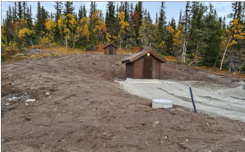
Figur 3-8. Etter oppussing av nedgravd basseng, Tverrlia Nesfjellet.
