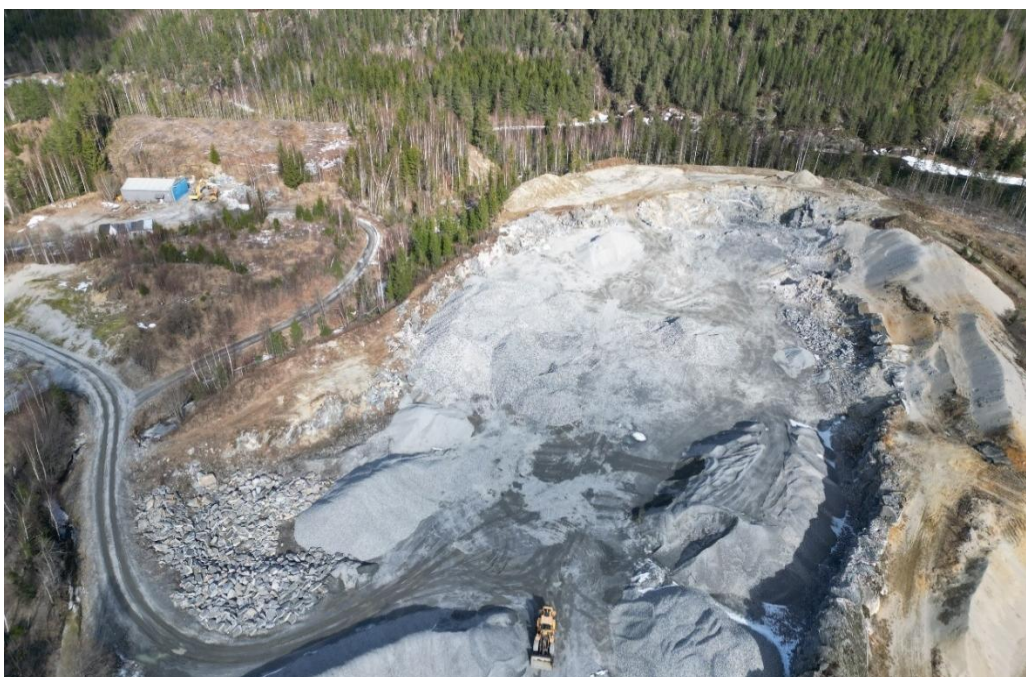
Figur 3-21: Dronebilde av grustak like ved, på andre sida av RV. 7. Viser at massane i området hovudsakleg er grus. Og noko fast berg.
