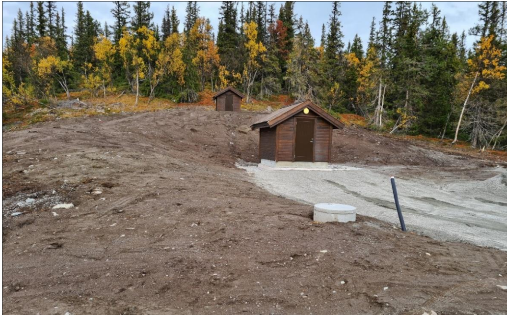
Figur 3-8. Etter oppussing av nedgravd basseng, Tverrlia Nesfjellet.
