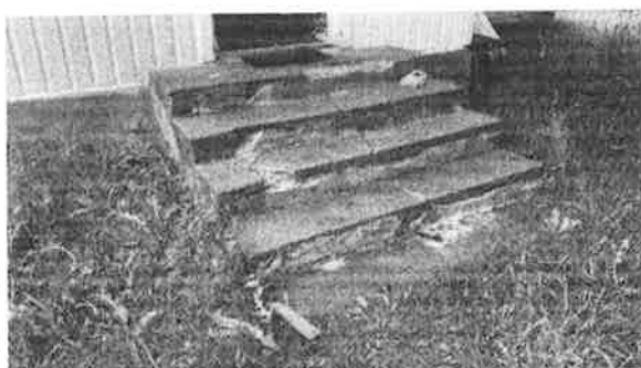
Trapp til inngang boligen.
