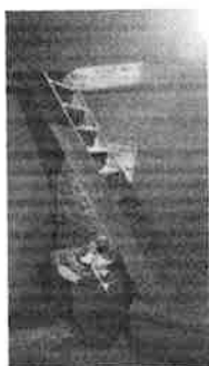
Trapp mellom 1. etasje og kjeller.
