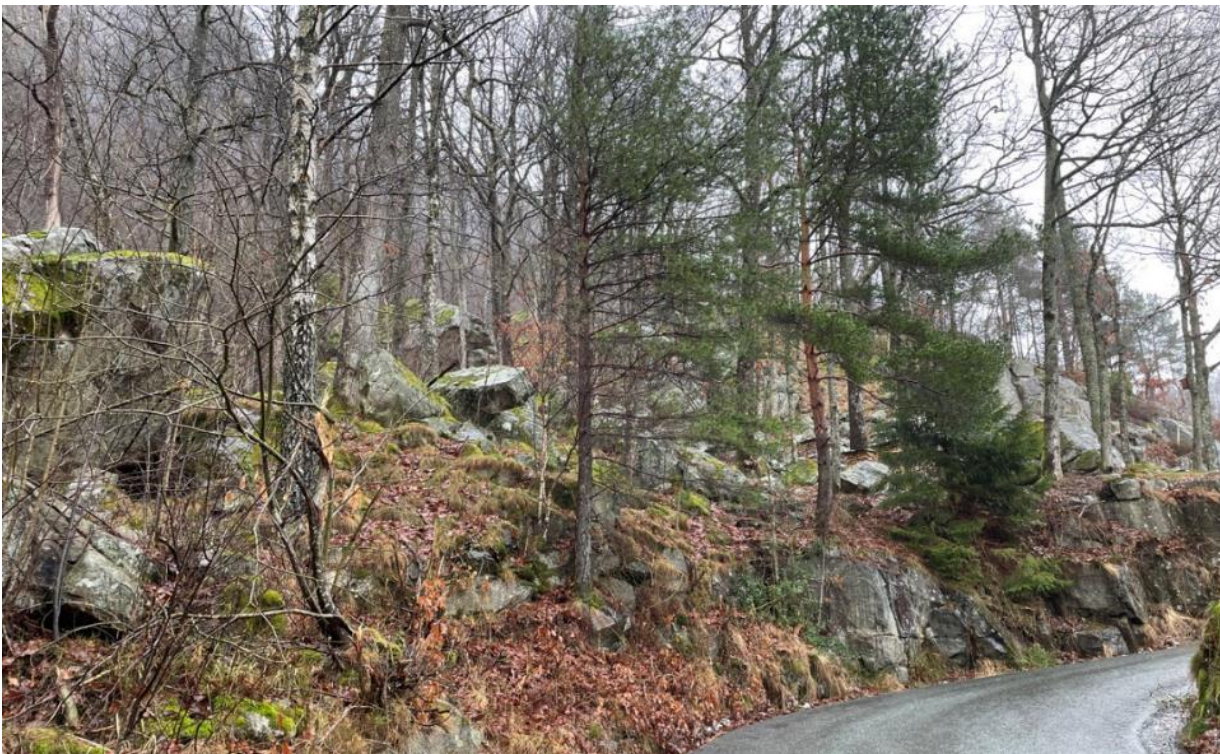
Bilde 4. Steinsprangblokker som har nådd helt ned til vei som går til boliger. Informasjonspunkt nr. 3 i vedlegg 5. Bildet er tatt mot øst.
