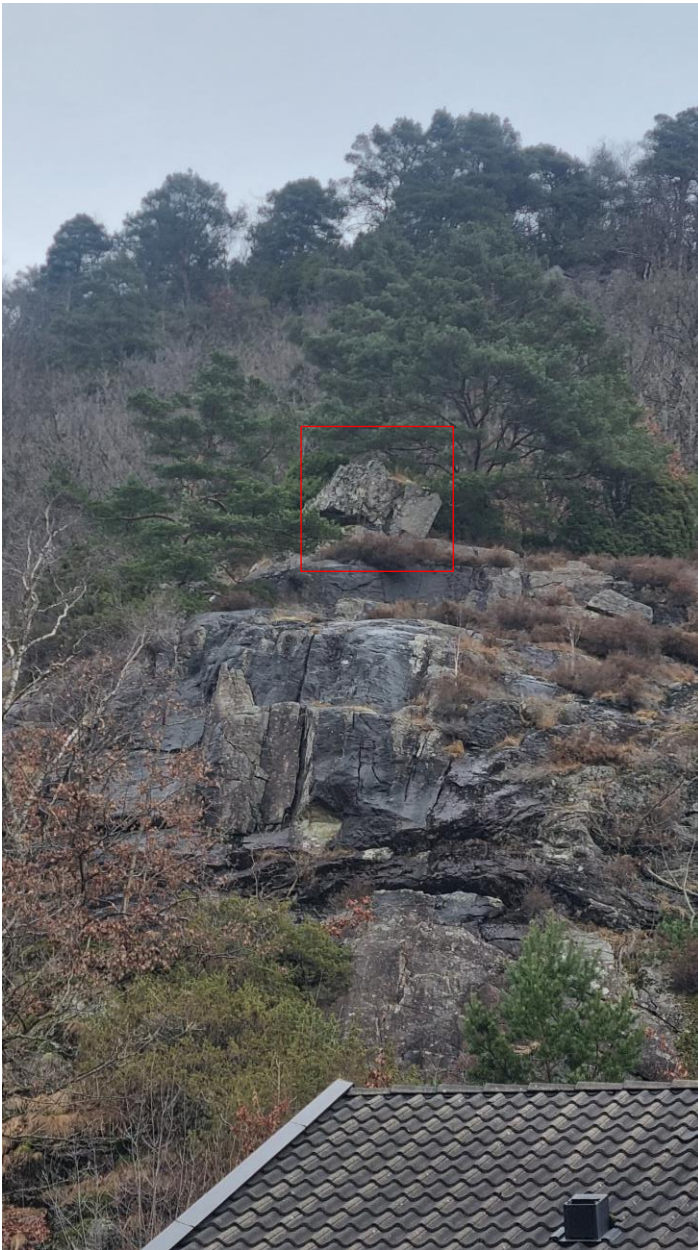
Bilde 17. Bergknaus, der det observeres en steinsprangblokk nær kanten av knausen. Informasjonspunkt nr. 10 i vedlegg 5. Bildet er tatt mot nordøst.
