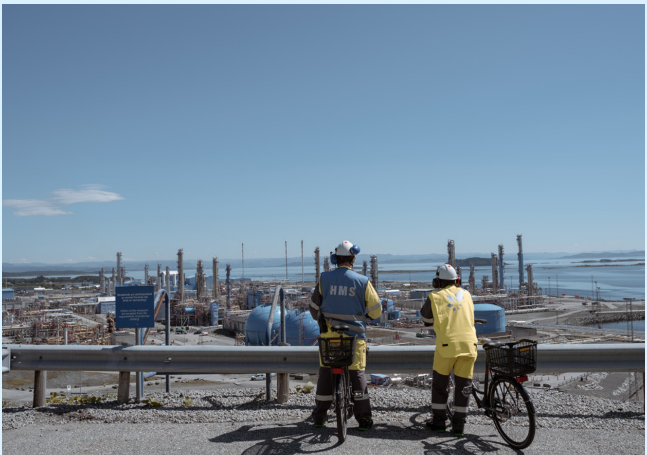
Kårstø-anlegget i Tysvær kommune. (Foto: Equinor)
