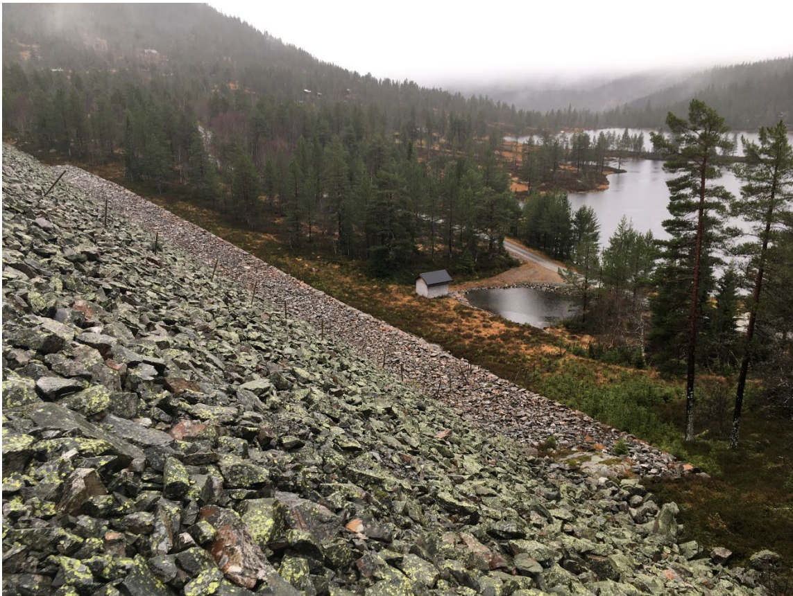
Luftsiden av dammen. Vei til hytteområdet i bakgrunnen.
