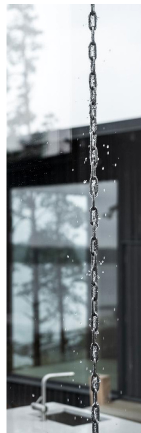
Ref. Kjetting nedløp, Villa furuholmen Arkitekt :Strå arkitekter Foto : Thurston Empson
