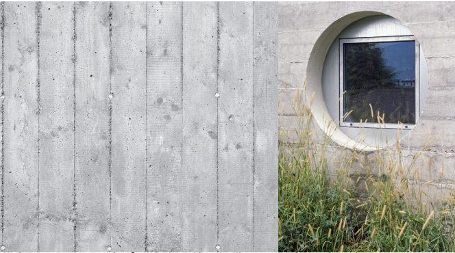
Ref. Betong - støpt i stående bordforskalling Ref. Hus i Sveits Arkitekt: Madeleine Architectes Foto: Severin Malaud
