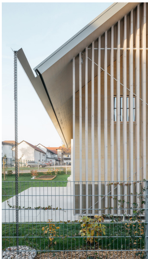
Ref. Kjetting nedløp, Hus i Slovenia Arkitekt :A202 Arkitekti Foto : Ana Skobe
