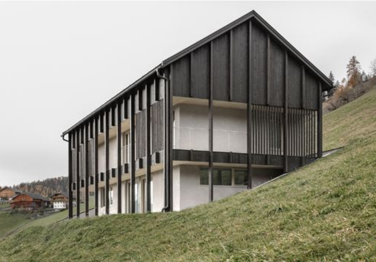
Ref. Ciasa Le Fiun House, Marebbe, Italiy Arkitekt :Architect Daniel Ellecosta Foto :Gustav Willeit
