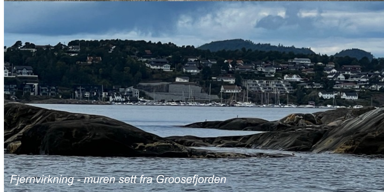
Mur langs Gooseveien i Grimstad
