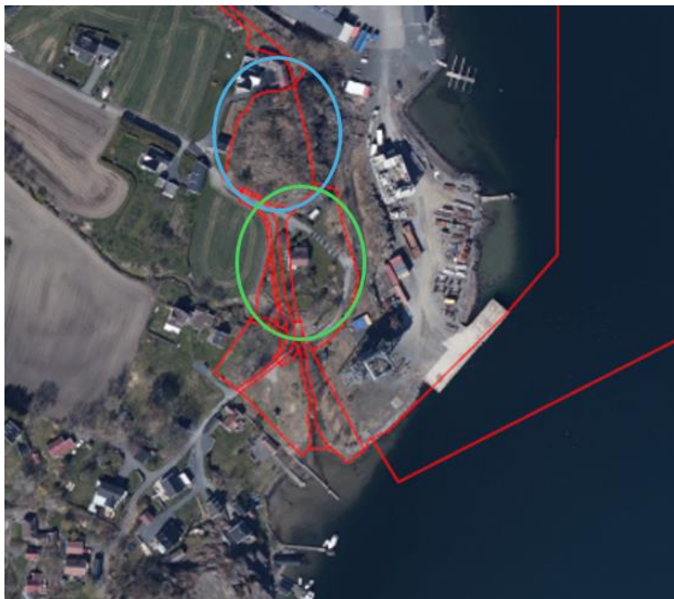
Figur 26: Oversiktskart viser område som er sprengt ut (blå sirkel) og området som skal sprenges ut (grønn sirkel) ved Gjømlebekken.
