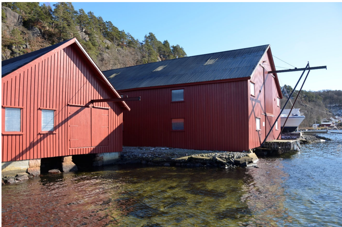
Figur 2-18: Befaringsbilde fra østsiden av Vikkilen, mot båthus sørover langs Vikkilen.
