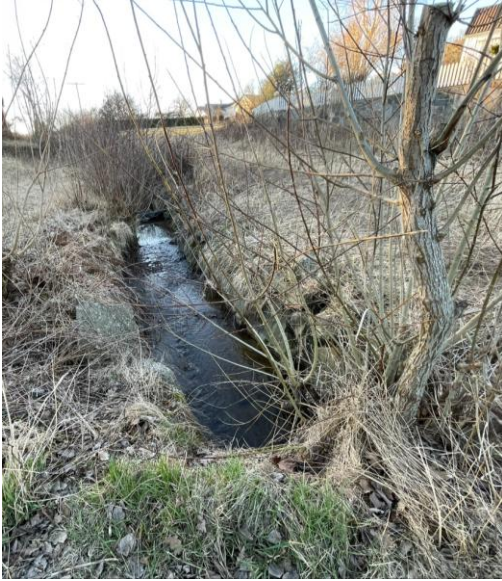
Gjørlebekken sett fra veien mot nord.
