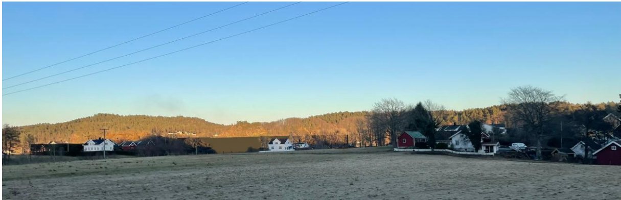
Figur 49: Foto fra Skjeviga som viser utbyggingsalternativet.
