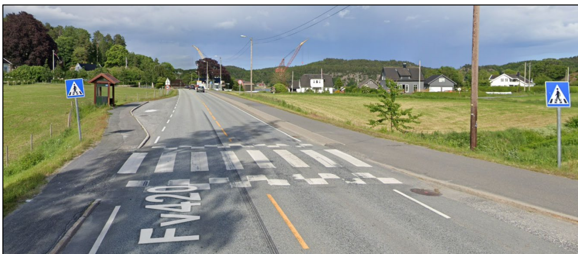
Figur 2-8: Gangfelt over fv. 420 J. M. Uglands vei ved bussholdeplass Ugland. Gang-/sykkelveien langs fylkesveien er separert fysisk fra veibane med opphøyd rabatt. (Google Street View, juni 2022)
