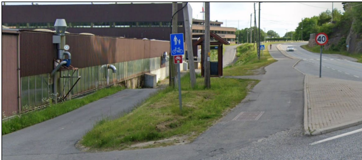
Figur 2-7: Gang-/sykkelvei og bussholdeplass langs fv. 420, sett fra kryss ved fv. 3620. (Google Street View, 2022)
