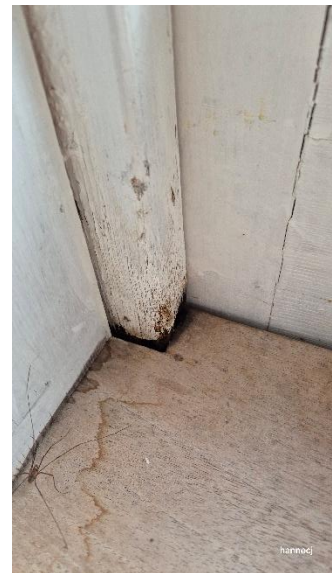
Fuktskader på innsiden av terrassedøren
