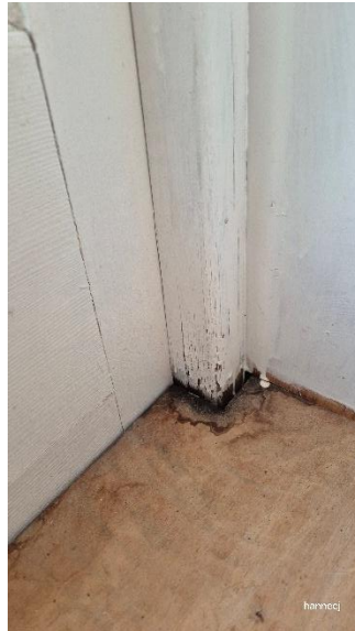
Fuktskader på innsiden av terrassedøren
