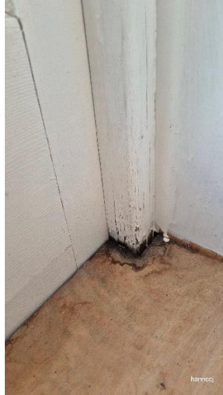
Fuktskader på innsiden av terrassedøren
