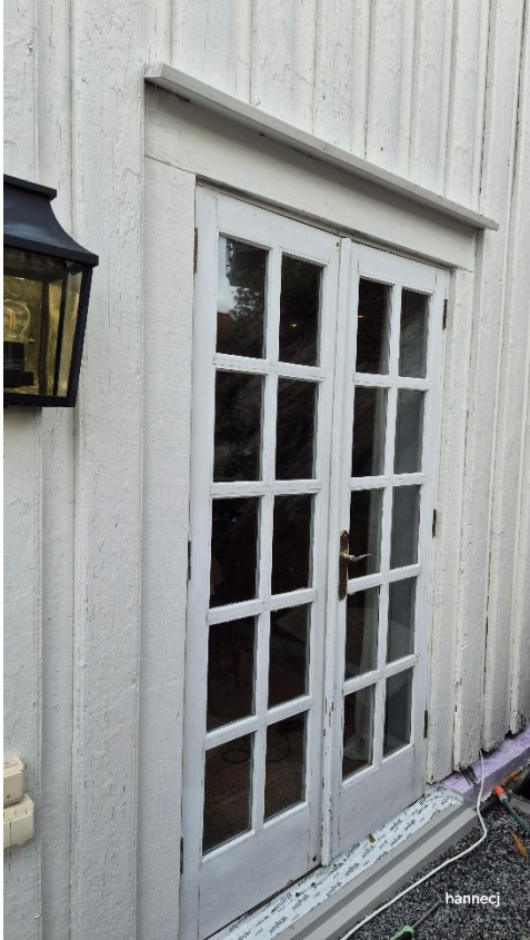
Terrassedør i gavlvegg mot sørøst
