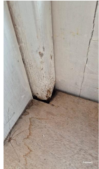
Fuktskader på innsiden av terrassedøren
