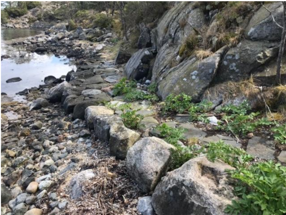
Del av kyststitrasséen langs sjøen i nord (foto 12.05.22)
