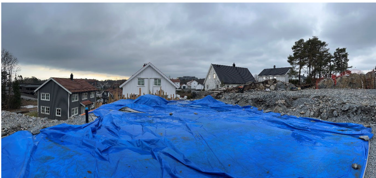
Figur 3 - B2 - tomt A – Tomten er klargjort for bygging, sett fra nord
