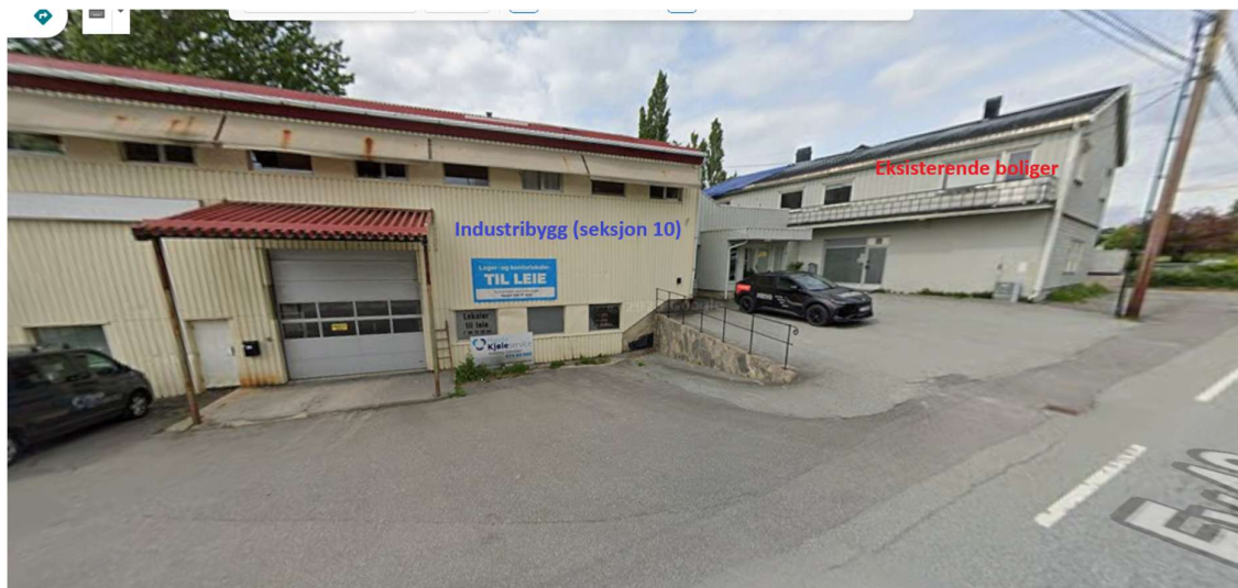
Bilde 1 viser industribygget (seksjon 10) og godkjente leiligheter (seksjon 1 og 33).
