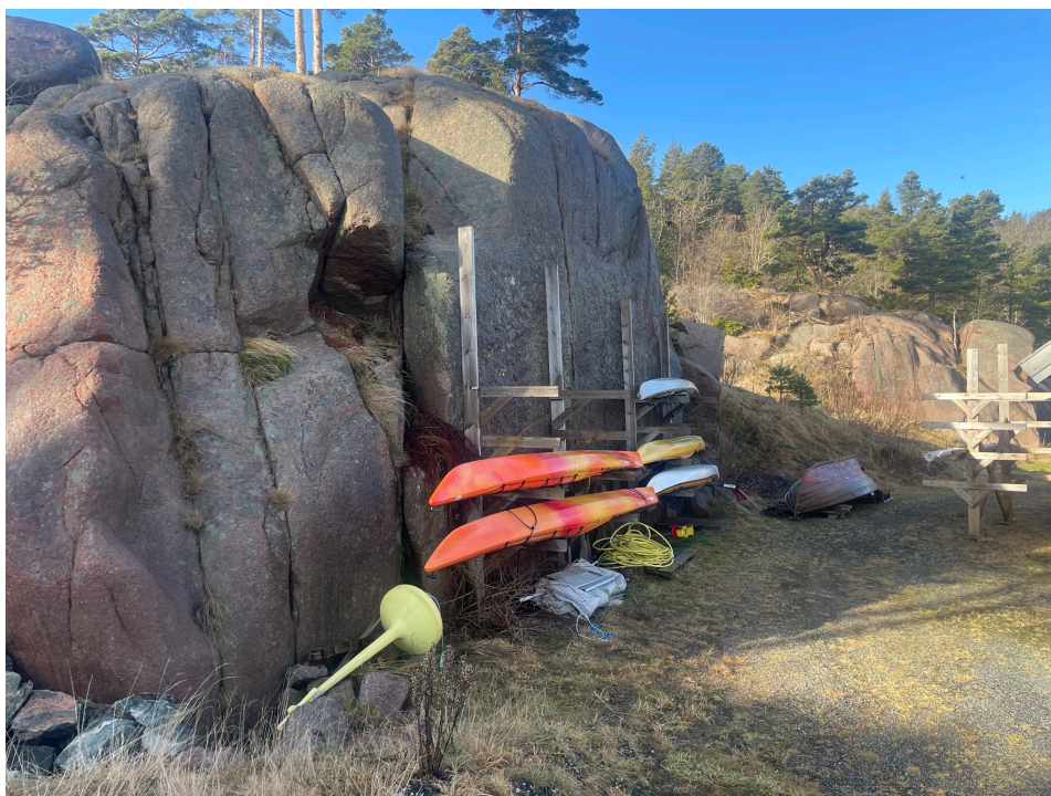
Figur 44 Sprengt skjæring som ser ut som en naturlig fjellvegg. Skraviga, Fevik
