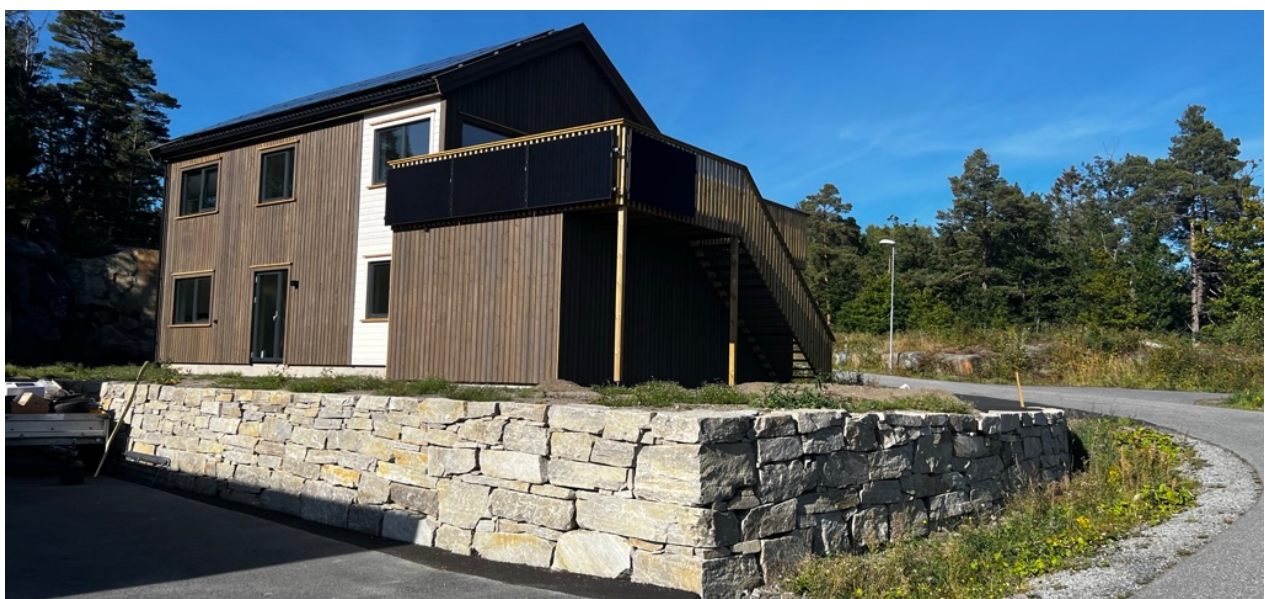
Figur 12 1' Tørrstabledt mur i Kjæråsen
