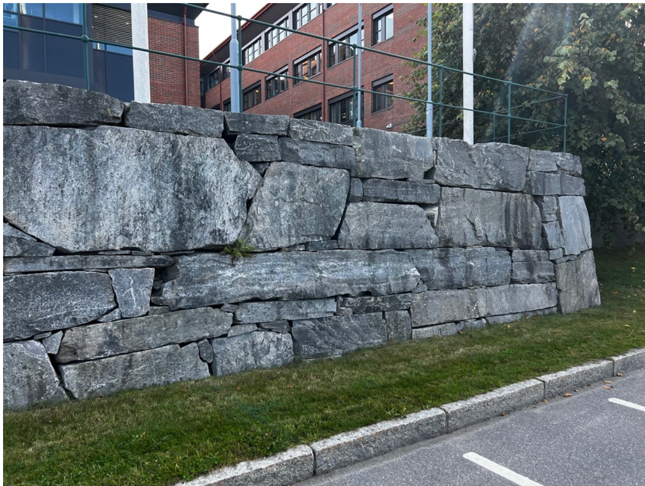
Figur 18 Natursteinsmur med varierte steinstørrelser
