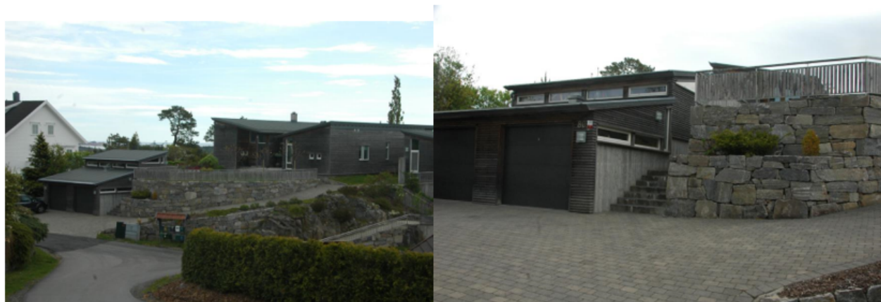
Figur 27 Mur med terrassering i Langestrand
