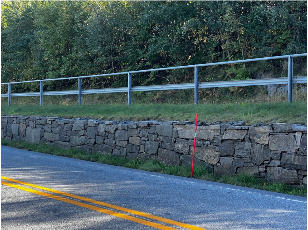
Figur 30 Mur i Øygårdsdalen
