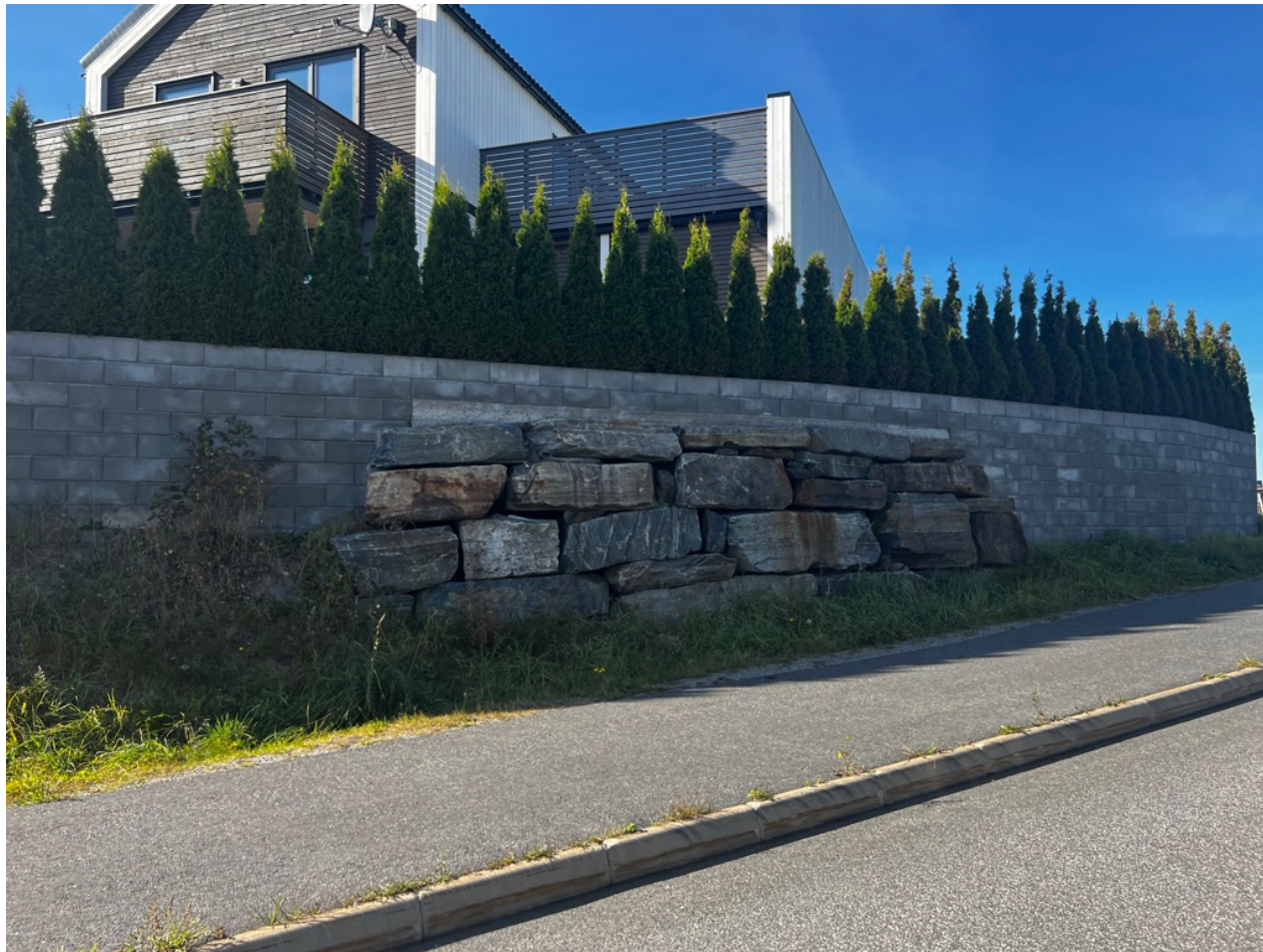
Figur 15 4' Forstøtningsmur i Kjæråsen
