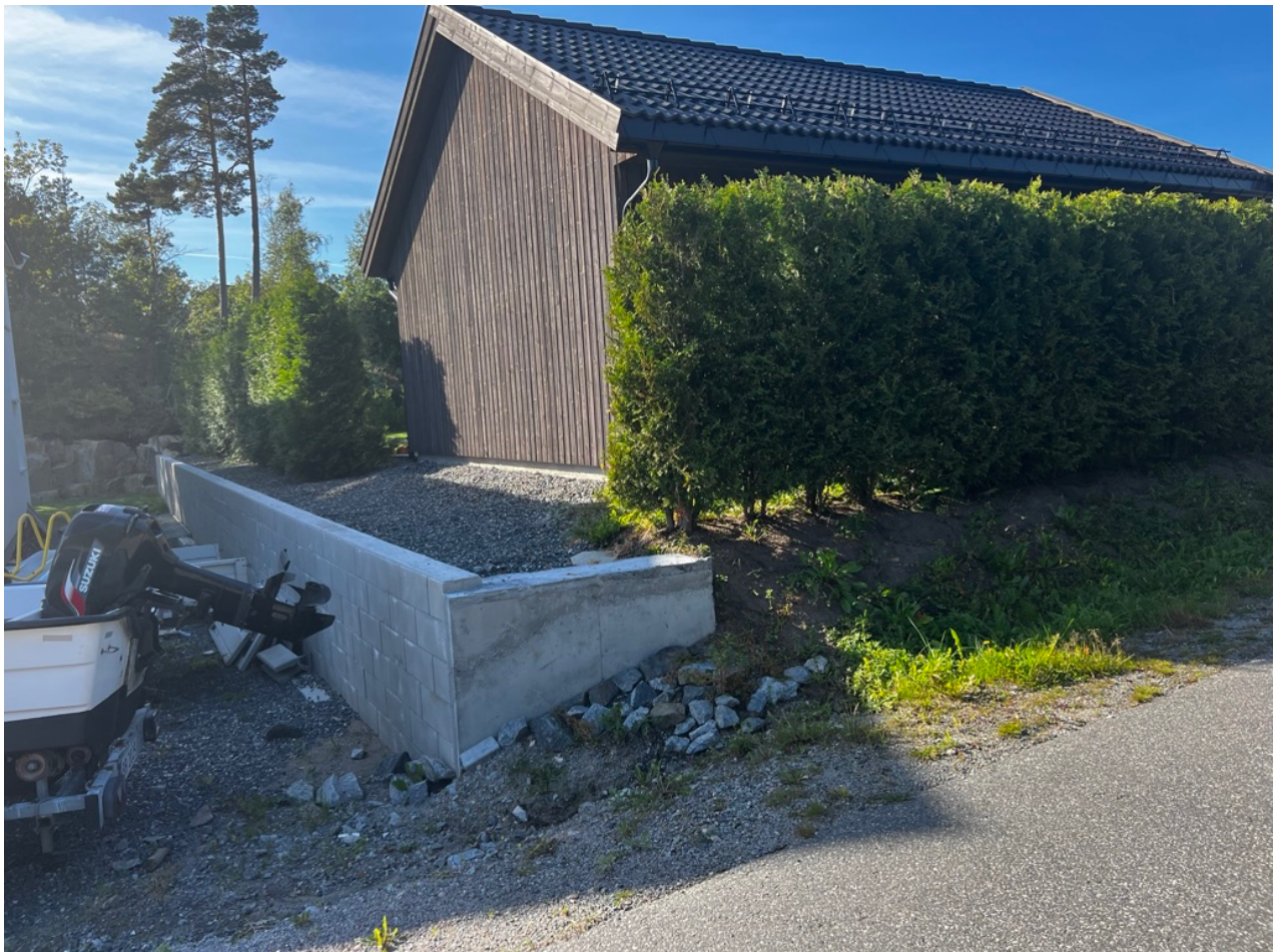
Figur 14 3' Forskalingsblokkmur i Kjæråsen
