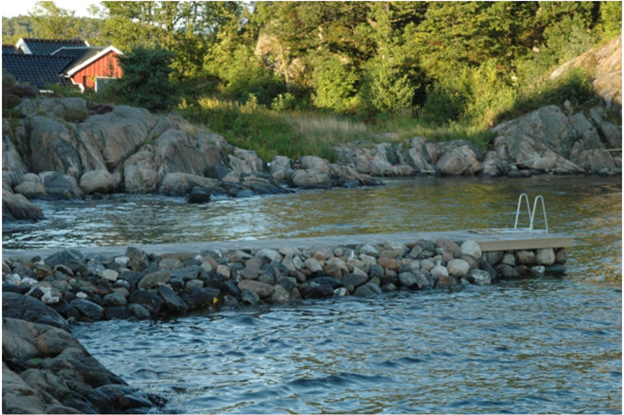
Figur 43 Steinfylling ved Vessøyneset
