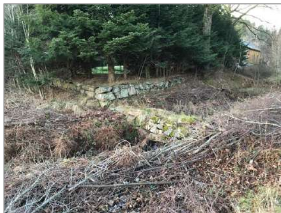
Natursteinsmur i bekkedrag mot Fjæreveien
