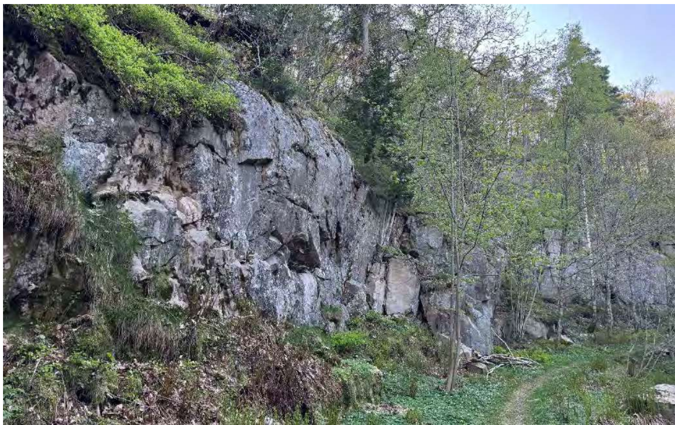
Figur 36 Infopunkt 15. Ved turstien som følger det slake terrenget gjennom kartleggingsområdet ble det observert oppsprekking og utløsning av steinsprangblokker av små dimensjoner. Bilde av Skrið as.
