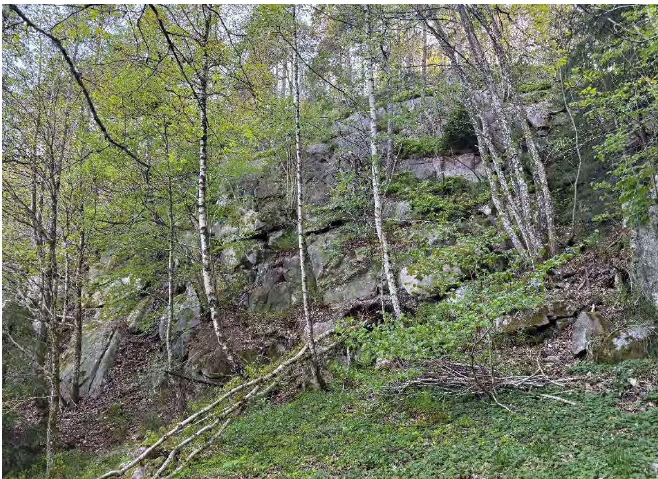
Figur 30 Infopunkt 9. Hovedvekten av areal med kritisk bratthet for utløsning av steinsprang (over 45°), fremstår med stabilt berg, stedvis med lav grad av oppsprekking. Bilde av Skrið as.
