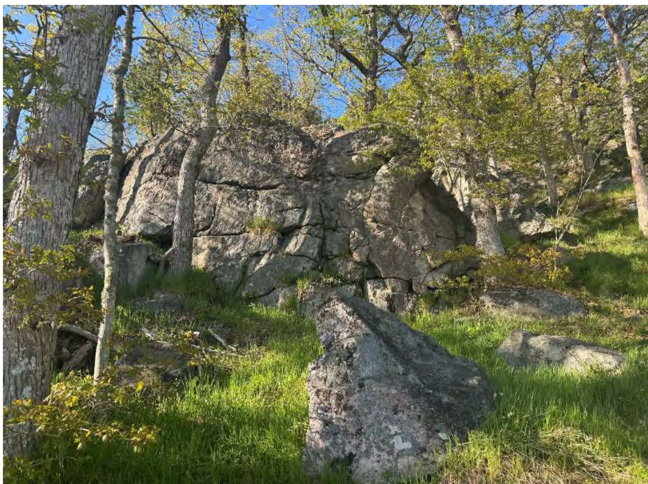
Figur 24 Infopunkt 3. Hovedvekten av areal med kritisk bratthet for utløsning av steinsprang (over 45°), fremstår med stabilt berg, stedvis med lav grad av oppsprekking. Steinsprangavsetning vurdert av eldre alder i terrenget. Bilde av Skrið as.
