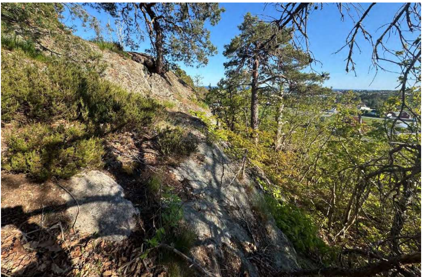
Figur 26 Infopunkt 5. Bergblotning med kritisk bratthet for utløsning av steinsprang, uten betydelig oppsprekking. Bilde av Skrið as.
