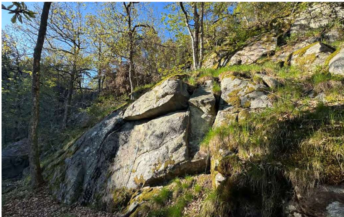
Figur 27 Infopunkt 6. Hovedvekten av areal med kritisk bratthet for utløsning av steinsprang (over 45°), fremstår med stabilt berg, stedvis med lav grad av oppsprekking. Bilde av Skrið as.
