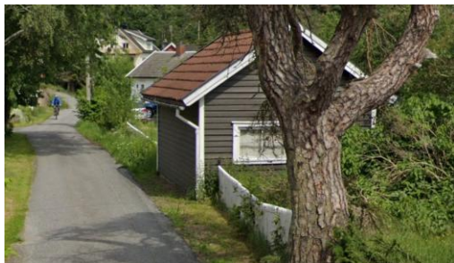
Eksisterende hagebod fjernes.
