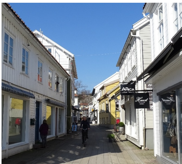
Figur 14: Grimstad sentrum består i hovedsak av to-etasjers trehus som ligger langs gateløpet.
