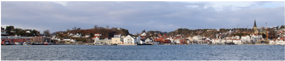
Figur 83: Dagens situasjon sett fra Rønnes. Torskeholmen sees i midten. Foto: Asplan Viak.
