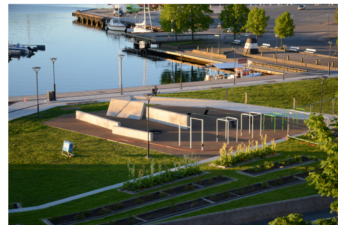
Gresskleddede områder. Betong og gummi på lekeplass.
