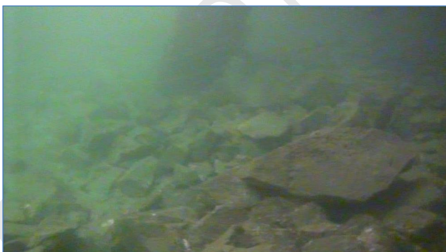
Bilde 39 - Bratt steinfylling med 50-100cm store stein på østsiden. Sørsiden inn under kaia har også litt finere masser med steinstørrelse på 30 – 50cm.
