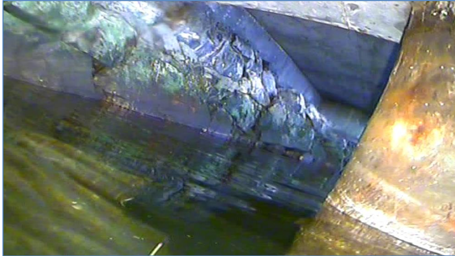
Bilde 34 – Stablestein mur inn under brygga på vest siden.
