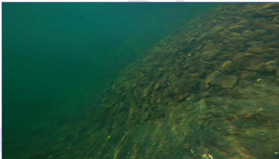
Bilde 37 - Bratt kultfylling ned til 1,5m dybde.
