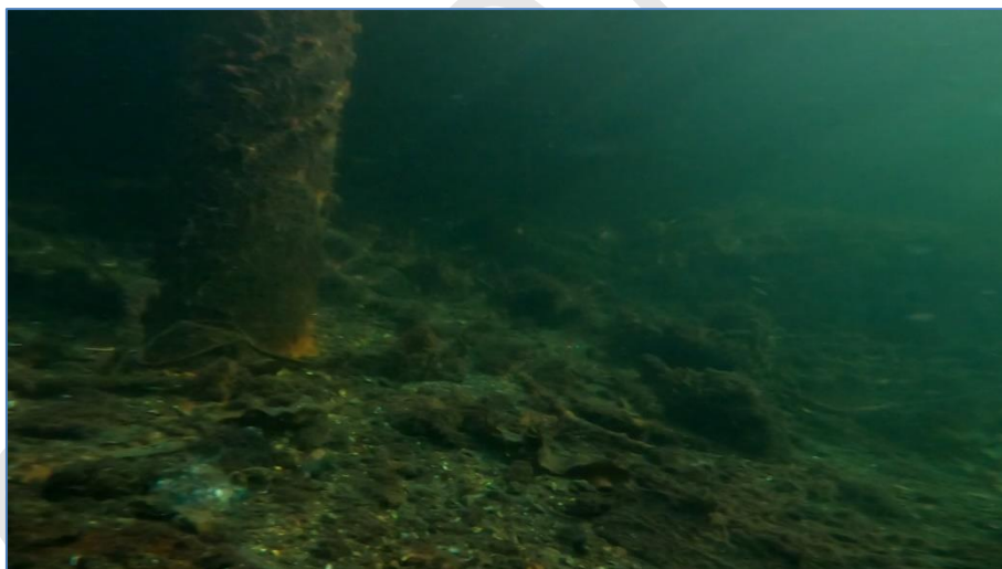
Bilde 33 - Viser Punktet. «Slutt fjell» Grov steinfylling (50cm-100cm steiner).
