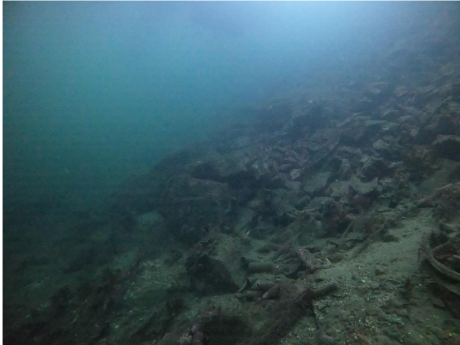
Bilde 12 - Bratt fylling ned til 6m dybde innerst ved «landfestet» til Torskeholmen.
