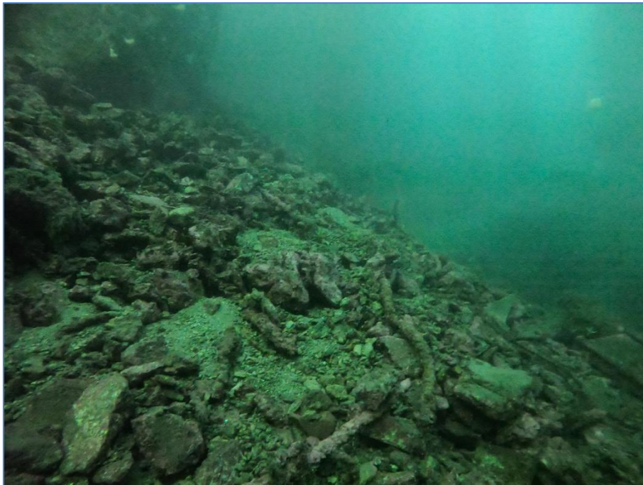
Bilde 22 - Steinfylling på hjørnet av brygga.
