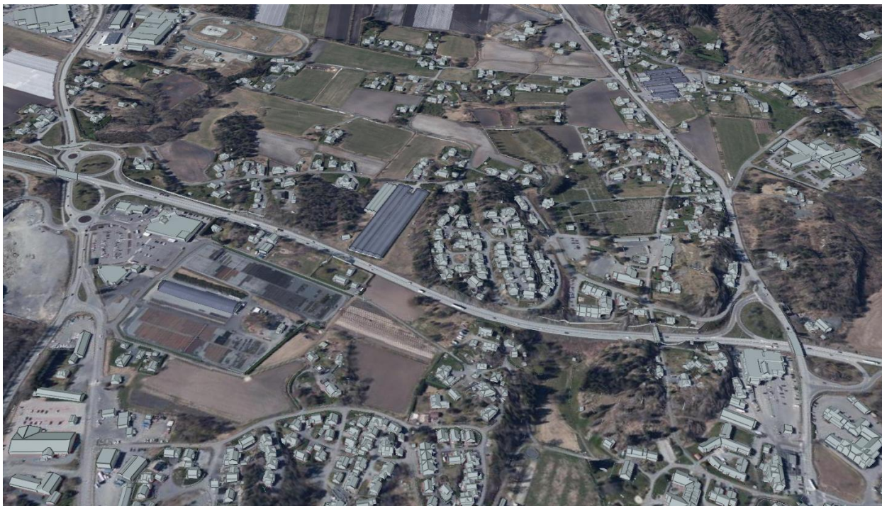
Figur 2-7. Oversiktsbilde over området Frivoll - Øygardsdalen. Kilde: Norkart sin 3D-løsning.
