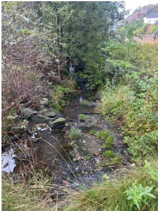
Figur 8 Befaringsbilde av bekken nedstrøms Båttstøveien. Fjellterskler og stein i bekken.
