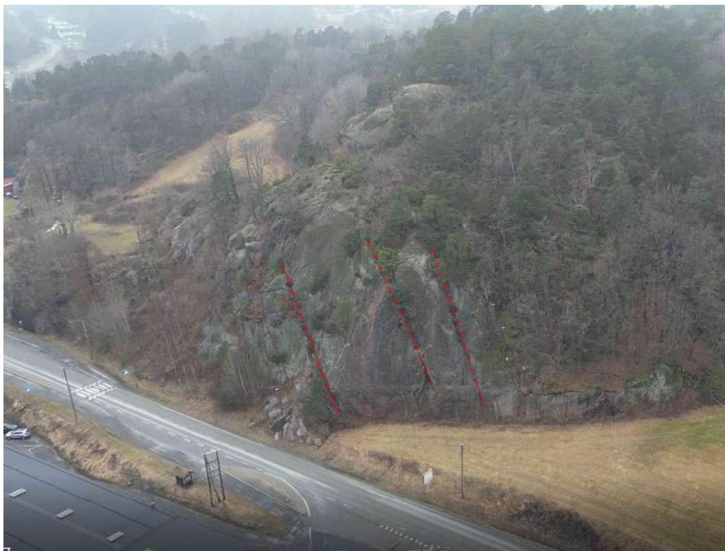
Figur 3-3: Dronefoto som viser den bratte bergknausen som ligger rett vest for Nymo verftsområde. Røde stiplet linje viser sprekker i berggrunnen. (Foto tatt mot sørvest) (Foto: COWI).
