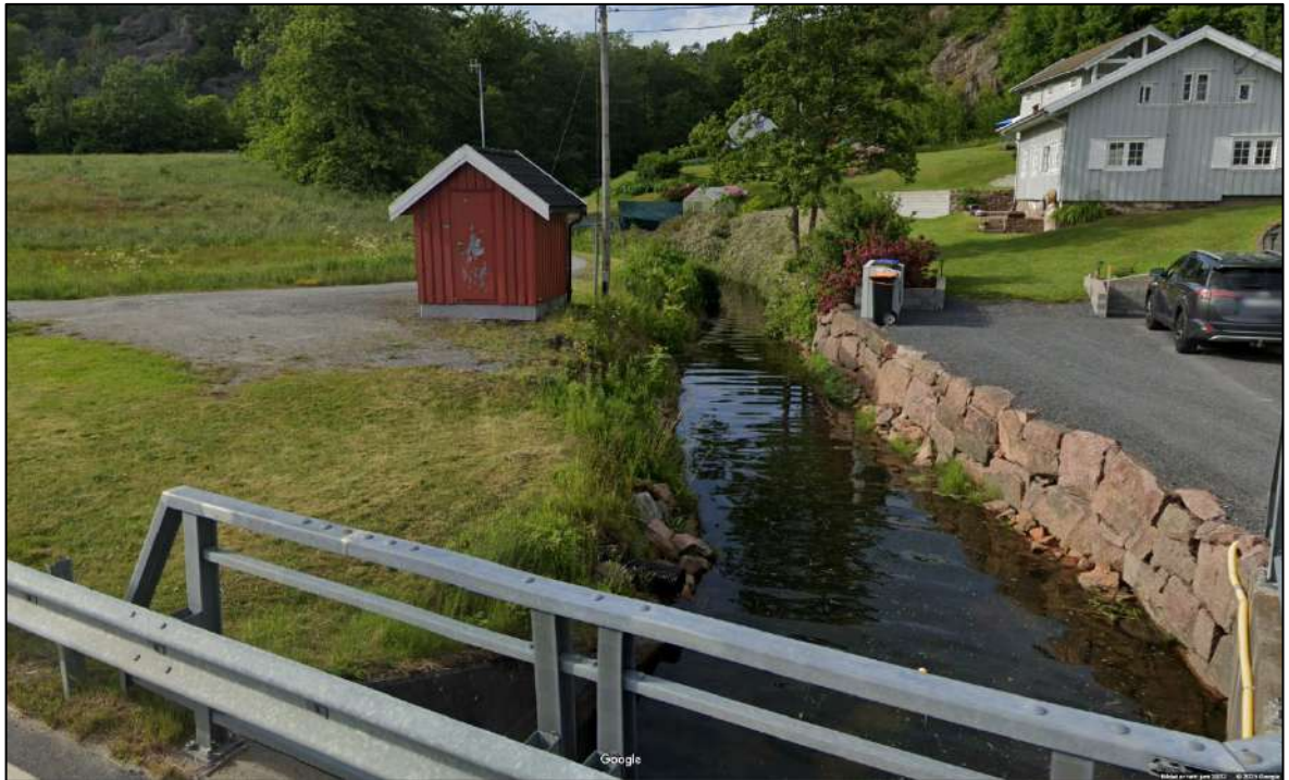
Figur 4-8: Sævelibekken langs kvikkleireområde på Sævelistranda, sett fra bru på Fv. 3620 Hesnesveien. Det er noe plastring med naturstein og utlagte blokker langs bekken. Utlipp fra Google Street View, juni 2022.
