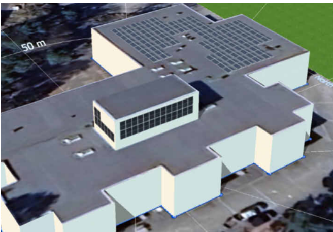
Perspektiv av tak, med solceller på fasadevegger på ventilasjonsrom
