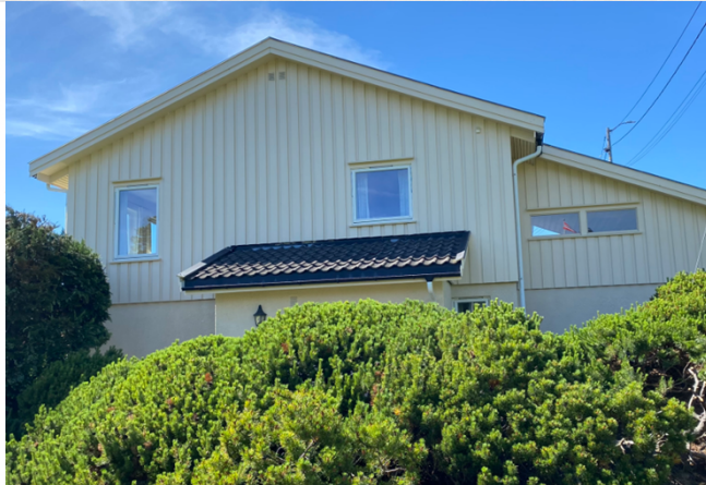
Bilde av fasade. Vindu over vindfang hører til tiltaket
