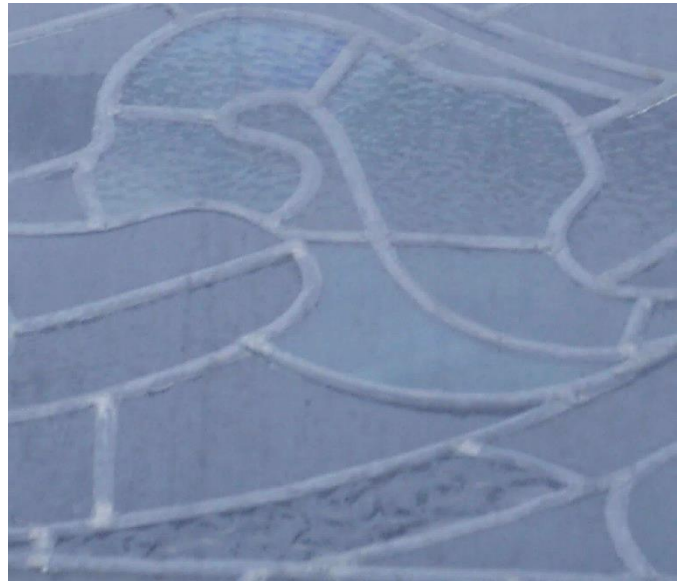
Foto fra utsiden av ett av glassmaleriene, som viser den teksturerte overflaten på glassbiter av støpt type. De øvrige er munnblåst type.
