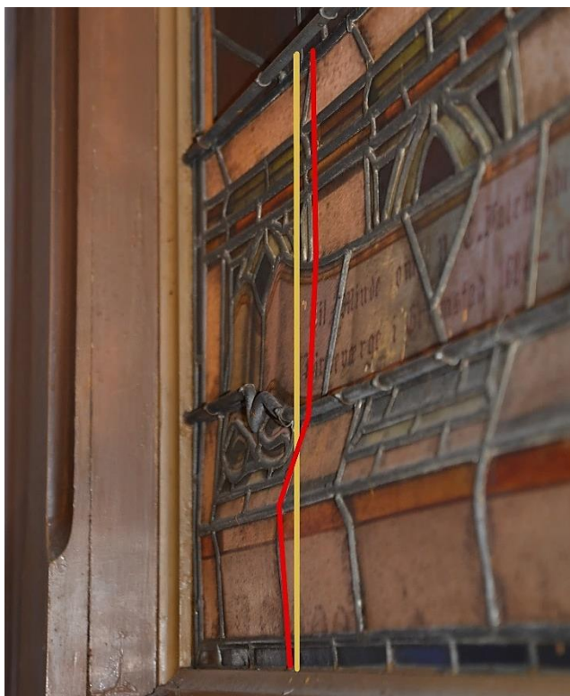
Illustrasjon av hvordan deler av felt a er deformert. Rød linje viser hvordan feltet er deformert, gul linje viser hvordan originalposisjonen var.
