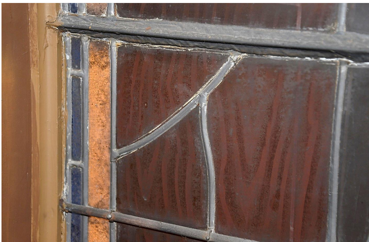
I øvre venstre hjørne har glassmalerifeltet begynt å skli ned, og glassbiter har begynt å løsne fra blyinnfatningen.
