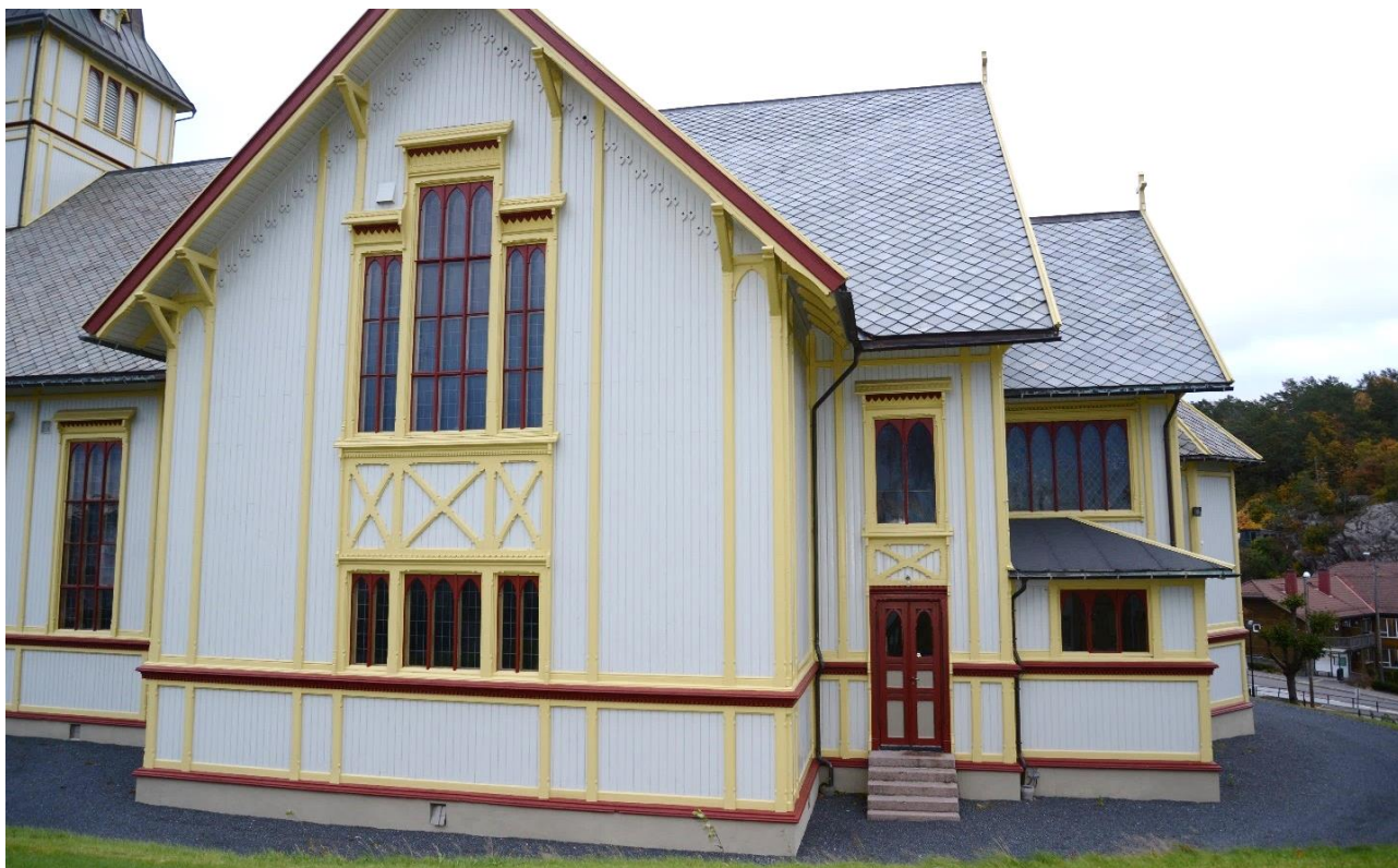
Det er beskyttelsesvinduer på både glassmaleriene og de øvrige blyglassvinduene i Grimstad kirke, alle montert på eksteriørsiden.
