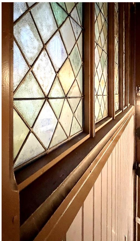
Glassmalerifeltene er montert i trerammer, med stormstag.
