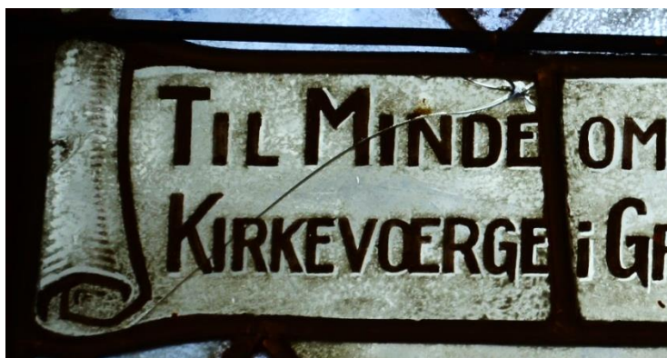
Bruddskader på glassbit på felt c, del av inskripsjonen til minne om kirkeverge Falchenberg. Denne glassbiten bidrar til å fortelle bakgrunnshistorien til glassmaleriene.
