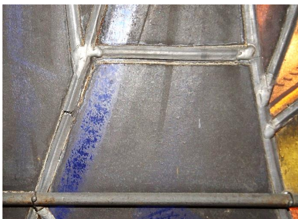
Fra felt Ø1a, med blybrudd og en glassbit som holder på å løsne fra blyprofilene.
