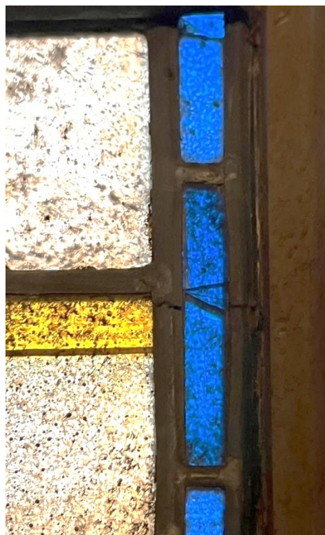
Eksempel på glassbrudd, i blå bordbiter på felt Ø1 a.
