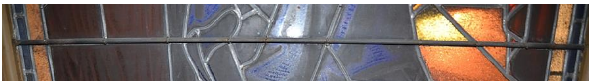
Eksempel på stormstag, festet i rammeverket på hver side, og til glassmalerifeltet. Fra felt Ø1a.
