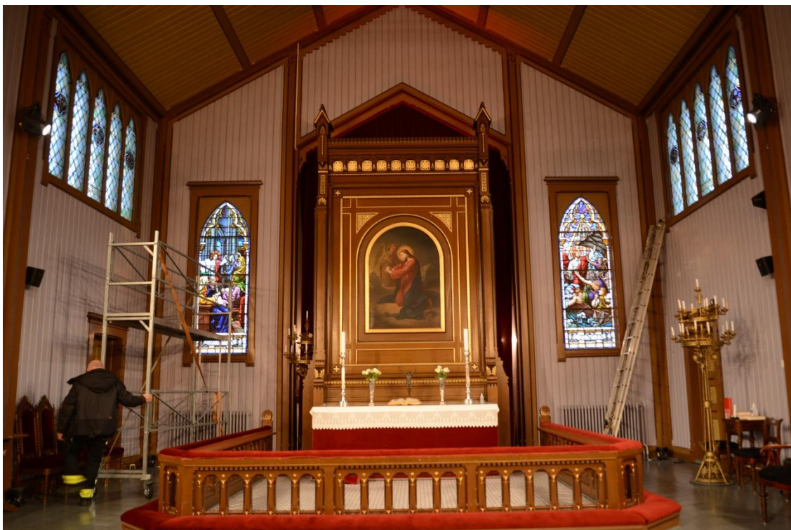
Både stillas og stige var tilgjengelig under befaringen, takket være driftsleder Håvard Backe.
