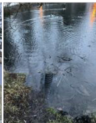
Inntak til utløpet
