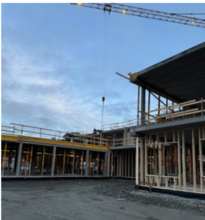
Hulldækker blir montert.
