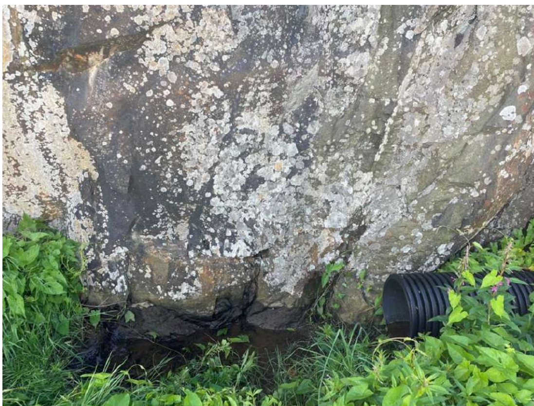
Figur 5-5 Utløp av overvannsrør ved Nalsteinveien ca. 10 meter nord for kaifronten
