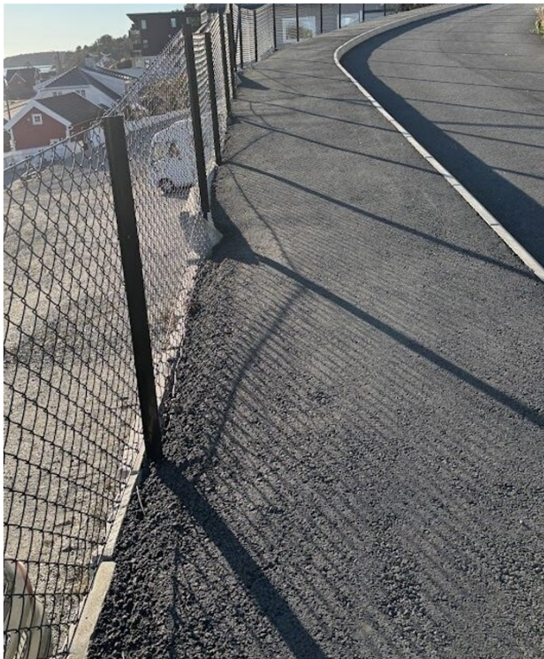
Figur 2: bilde av sikring langs vei opp til tomten.
