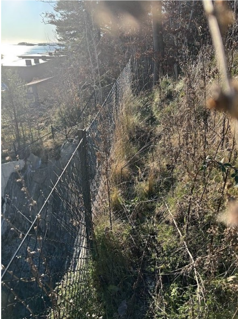
Figur 3: bilde av sikring på topp av mur mot nabo 3/100
