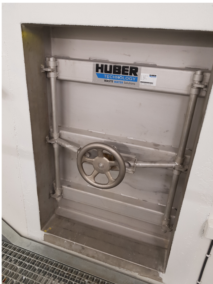
Figur 7-1: Vanntett mannluke sett fra tørr side. Kilde: Huber.de
