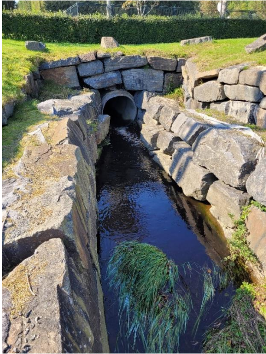
3) Kulvert under hovedvei inn til campingplass.
