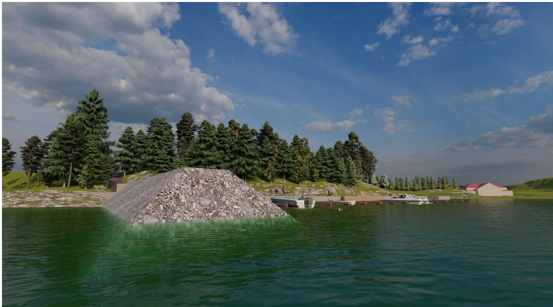
Figur 74 - Illustrasjon av bølgedemper/molo, med antatt byggehøyde, sett fra sjøen. (kilde: Halvorsen Arkitekter/Lindalgruppen)
