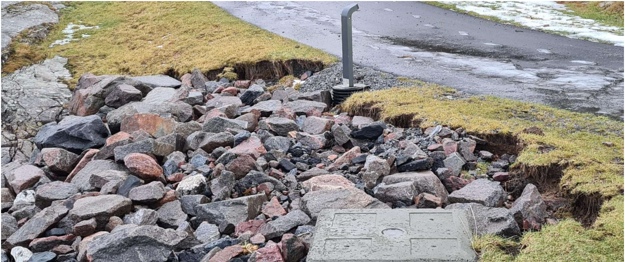
Figur 120 - Skade på eksisterende kyststien (Foto: Moysand familiecamping)
