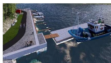
Figur 2 - Illustrasjon av småbåtanlegg med flytende bølgedemper/molo. (kilde: /Lindalgruppen)
