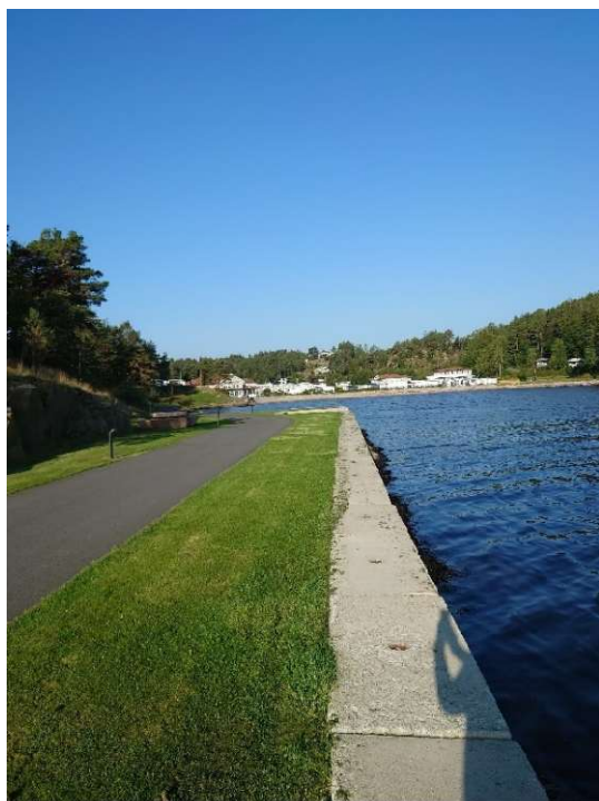
Figur 50 - Kyststiene ligger bak etablert brygge, sett mot butikkbygget på campingplassen. Foto: EgdePlan
