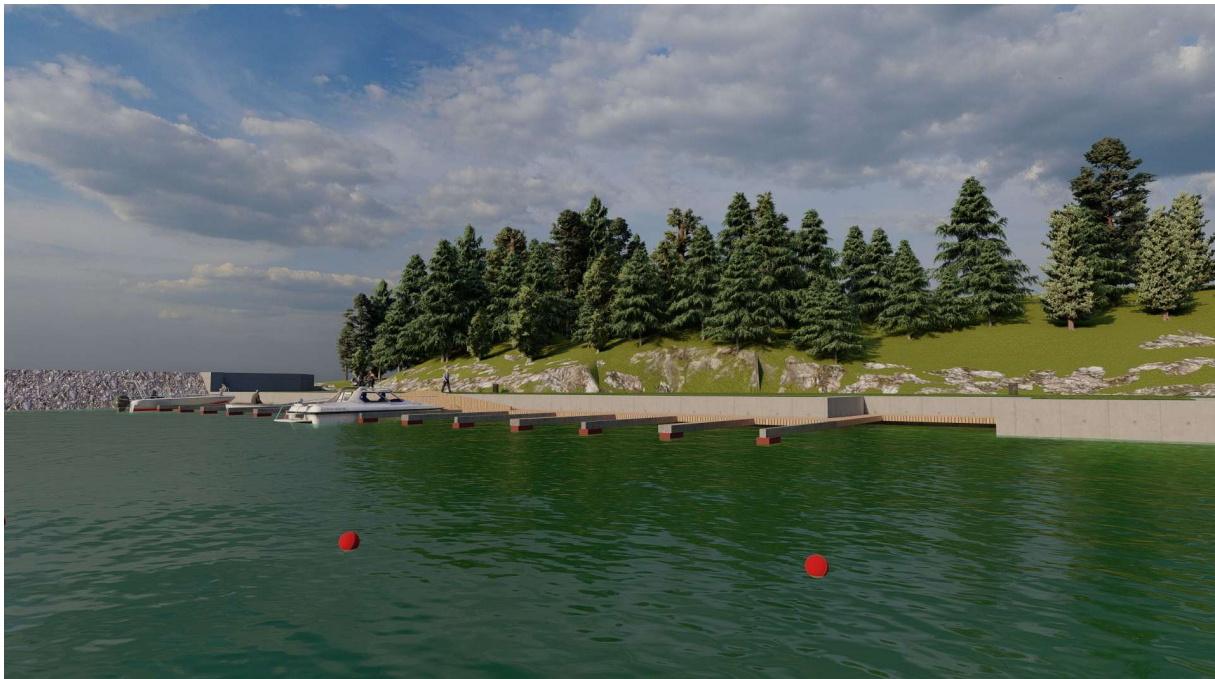
Figur 76 - Illustrasjon av alternativet med bølgedemper med steinfyllingsmolo (alternativ 1), med småbåthavn. Antatt byggehøyde på bølgedemper/molo. (kilde: Halvorsen Arkitekter/Lindalgruppen)
