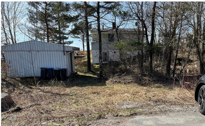
Nåværende bebyggelse sett fra Soloddveien (snuplassen) (foto 18.04.23)
