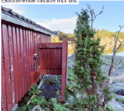
Eksisterende fasade mot øst
