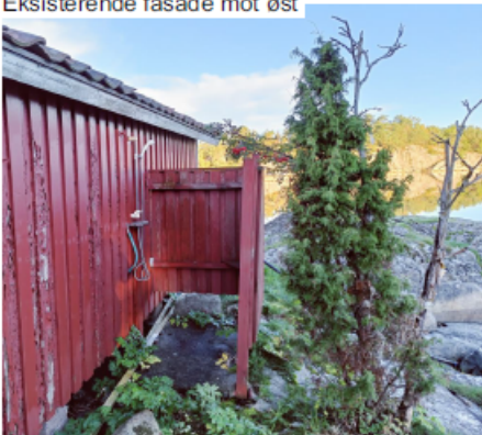
Eksisterende fasade mot øst
