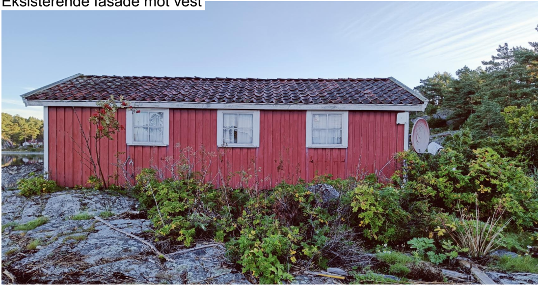
Eksisterende fasade mot vest
