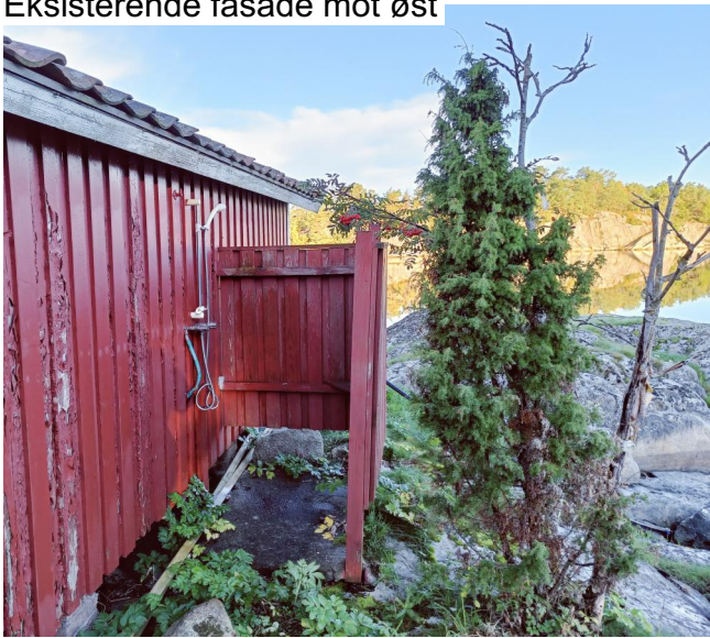
Eksisterende fasade mot øst
