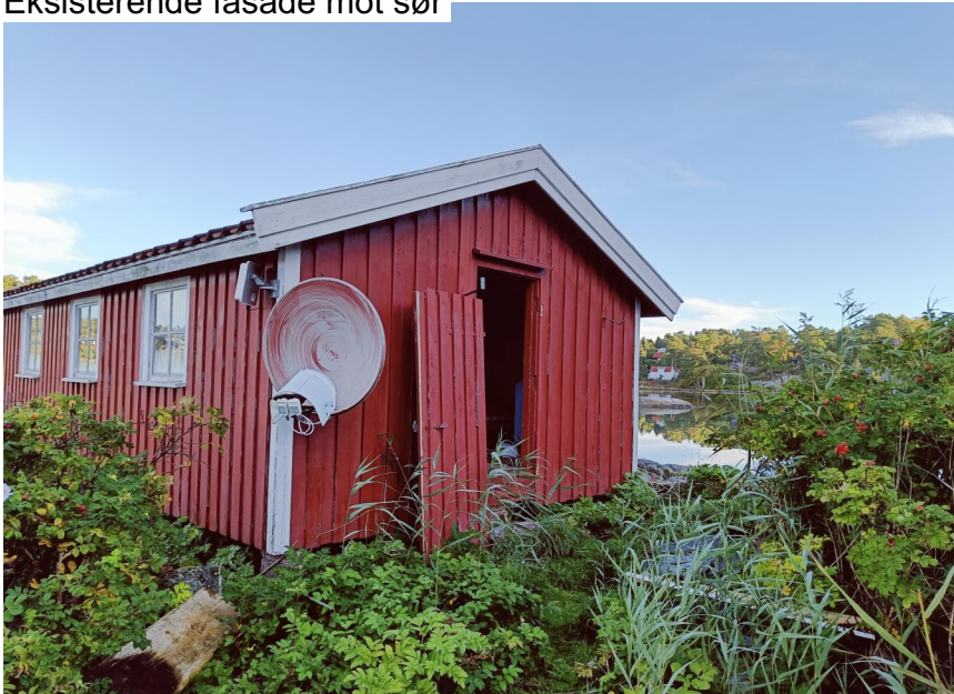
Eksisterende fasade mot sør
