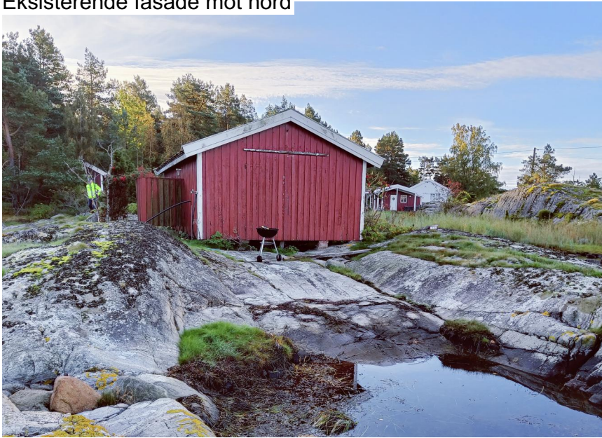
Eksisterende fasade mot nord
