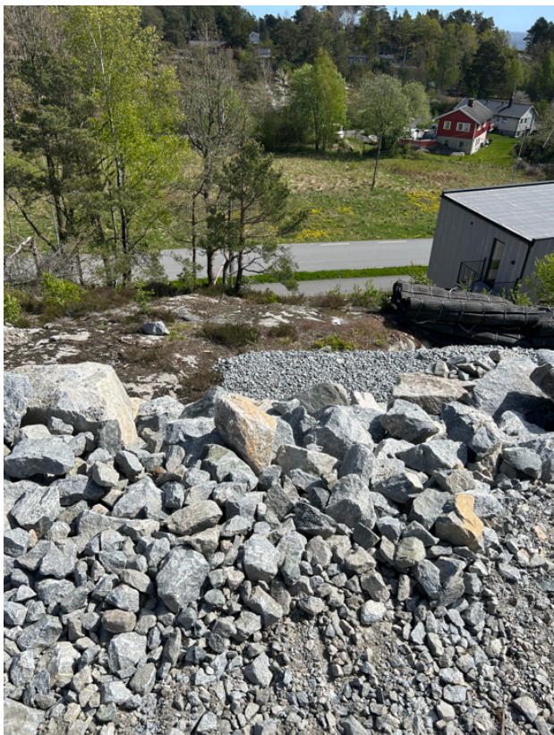
Bildet ovenfor er tatt fra ny gang og sykkelsti under utførelse i Brunåsen og ned på mitt hus, Støleveien 164
