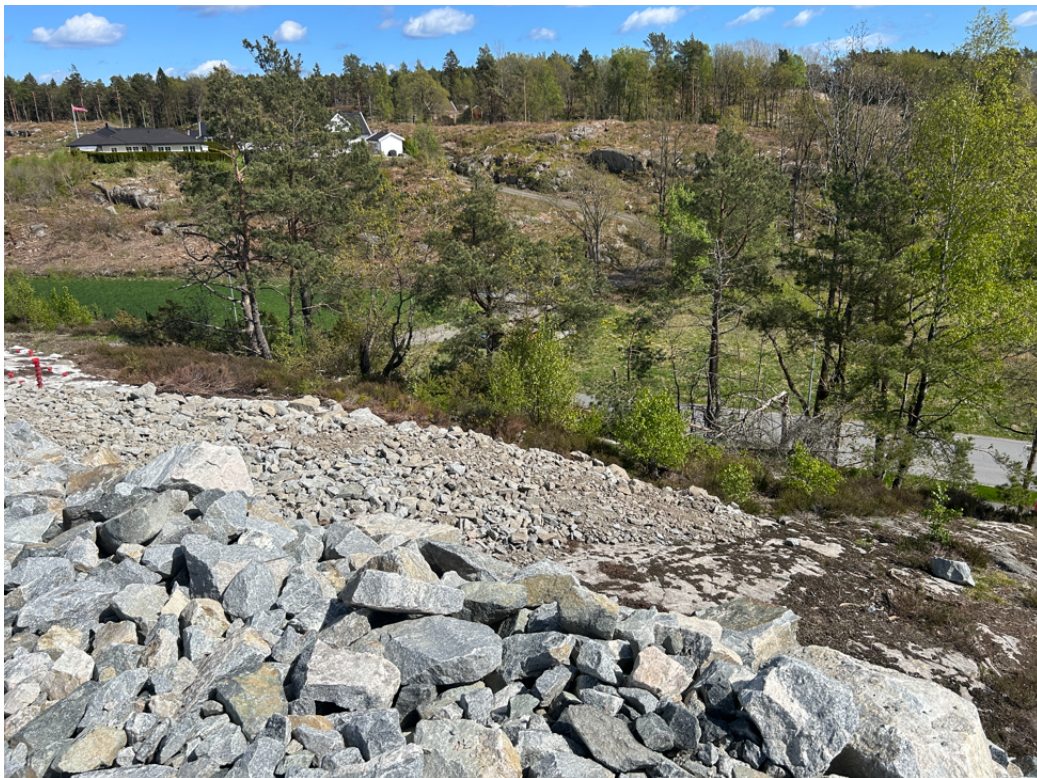
Bildet ovenfor tatt fra ny gang og sykkelsti under utførelse og ned på mitt grøntareal. Som det fremkommer er det en vesentlig høydeforskjell
