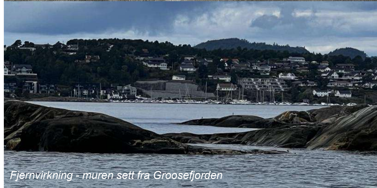
Mur langs Gooseveien i Grimstad
